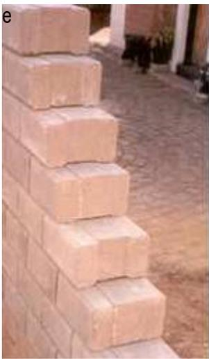
El sistema de construcción TERRASYSTEM® BRICK sustituye a los ladrillos y al mortero convencionales mediante el uso de los ladrillos TERRASYSTEM® BRICKs, que en su mayor parte se apilan en seco. Los demás componentes del sistema de construcción convencional permanecen inalterados.
