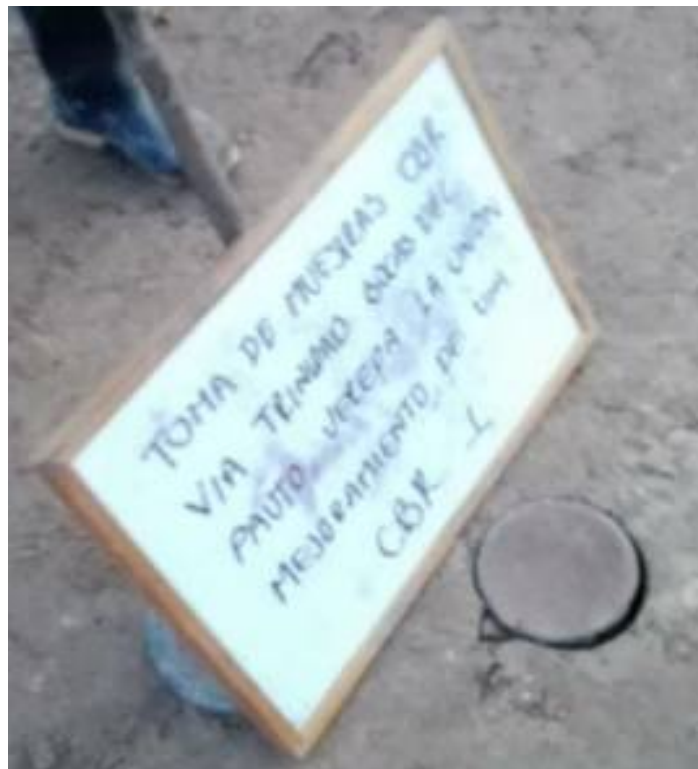
FOTO No 15 TOMA CBR EN SITU A LOS 10 MINUTOS DE COMPACTADO
