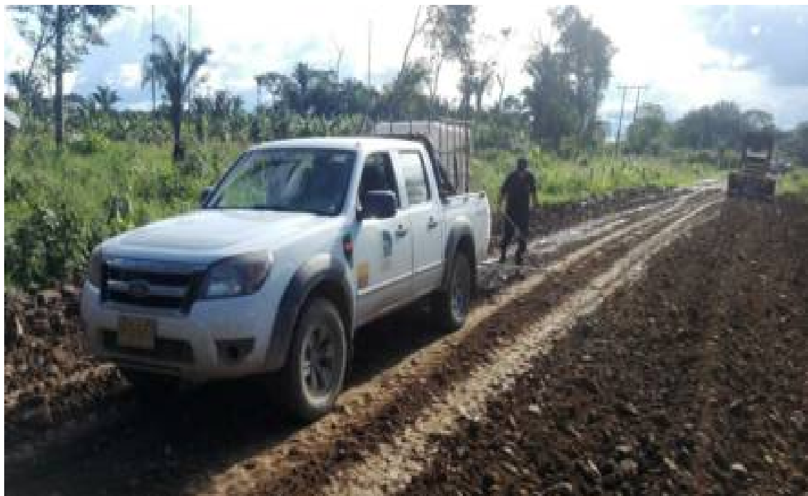
FOTO N° 12 A LA IZQUIERDA SE OBSERVA EL PROCESO DE APLICACIÓN DEL PRODUCTO TERRA-3000, MEDIANTE EL SISTEMA DE ASPERSIÓN POR GRAVEDAD.
