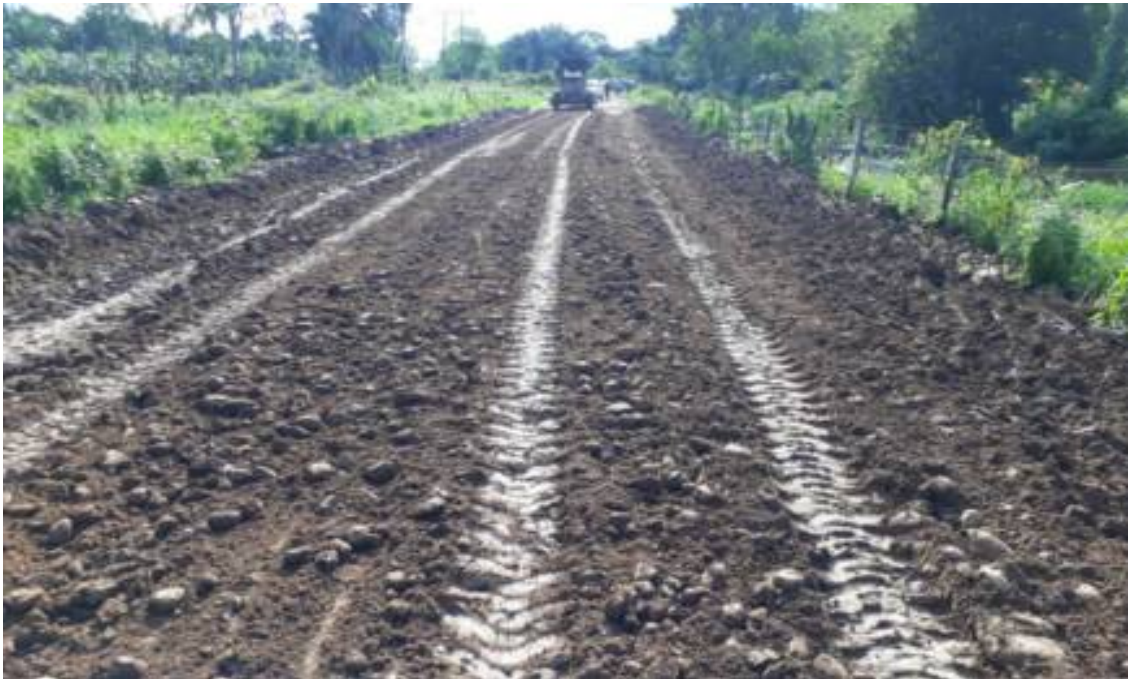
FOTO No 7 SE APRECIA GRAN CANTIDAD DE SOBRETAMAÑOS EN MATERIAL GRANULAR.
