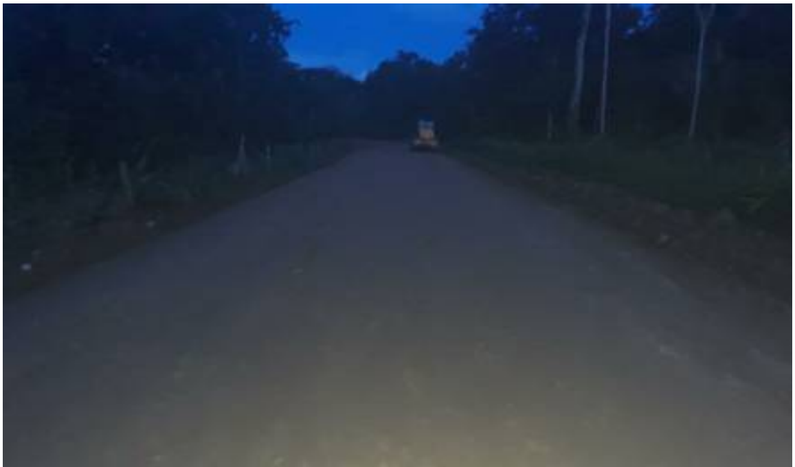
FOTO No 20 ESTADO FINAL DE LA VÍA
