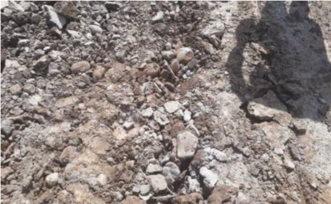
FOTO No 5 SE APRECIA MATERIAL GRANULAR Y ALTA PRESENCIA MATERIAL ARCILLOSO.
