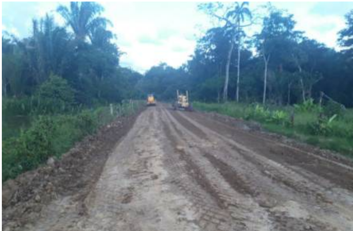
No 14 PROCESO DE SERIADO E INICIO DE COMPACTACIÓN.
