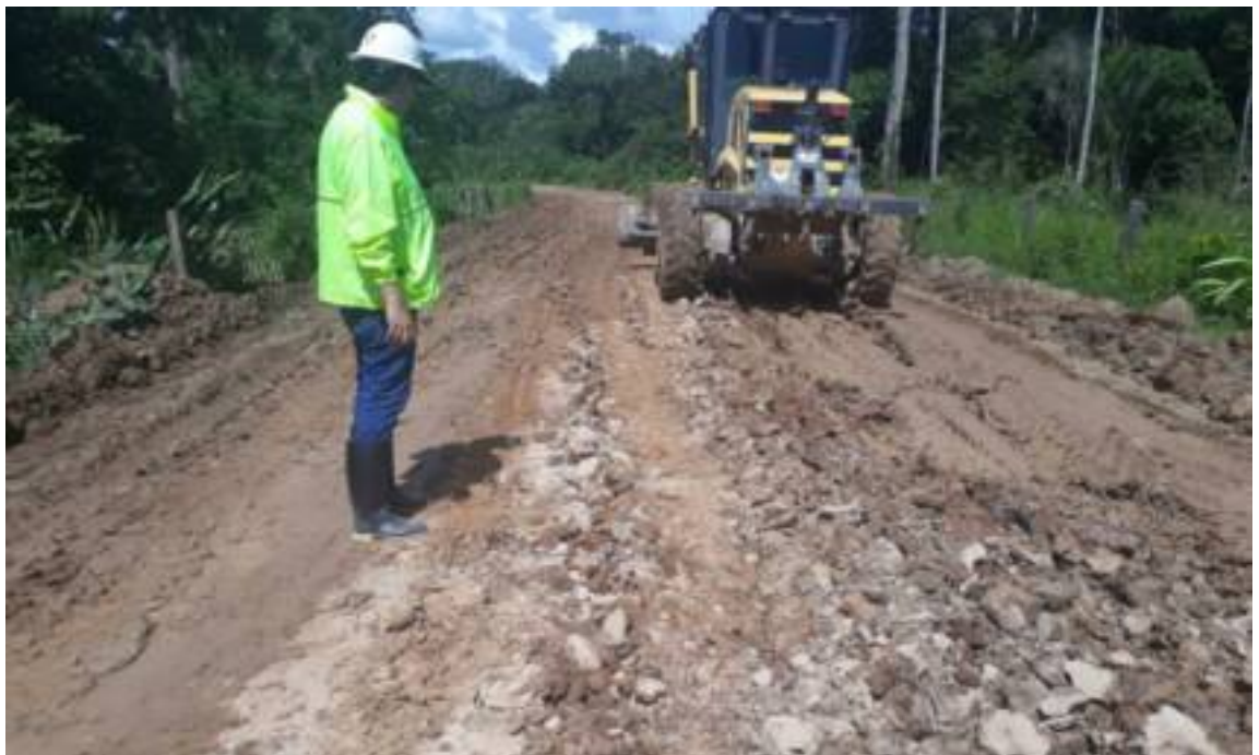
FOTO No 4 ESCARIFICACION DE LA VIA, PROFUNDIDAD 30 CM, SE APRECIA SOBRETAMAÑOS DE
