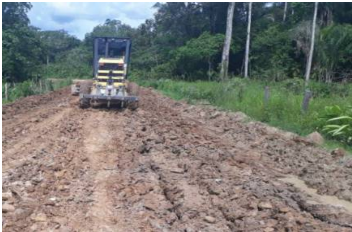
FOTO No 7 SE APRECIA GRAN CANTIDAD DE SOBRETAMAÑOS EN MATERIAL GRANULAR.
