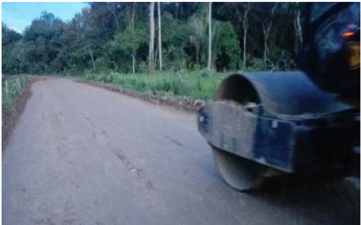
FOTO No 18 PROCESO DE COMPACTACIÓN FINAL.
